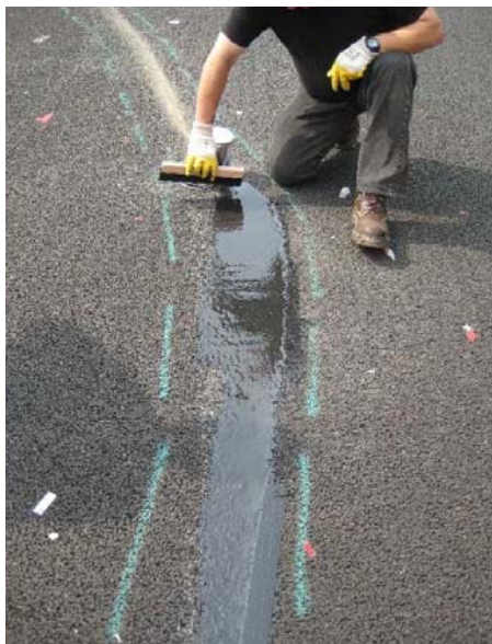
Fyllning av skada med TOK-Rep
