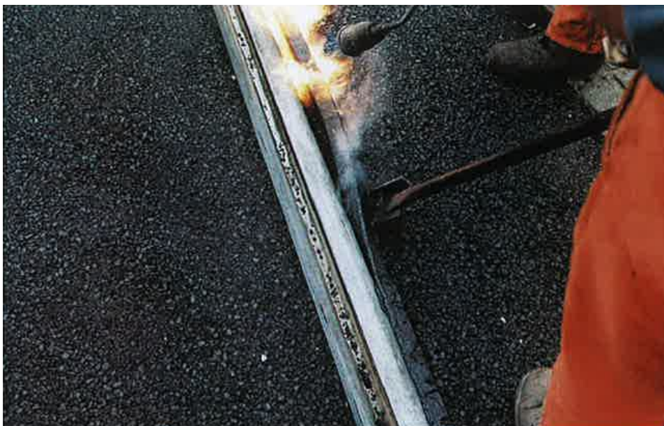
TOK-Band T flammass med mjuk låga innan det trycks fast
