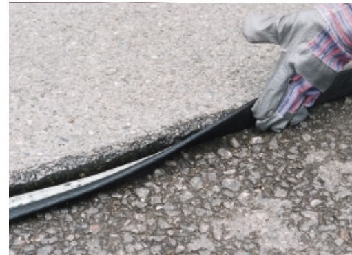
Bild 3 Tryck fast bandet mot kanten så att kanten vilar mot den plana delen på den gamla asfalten.
