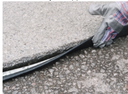
Bild 3 Tryck fast bandet mot kanten
