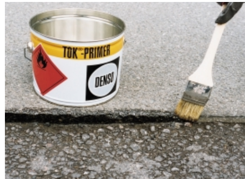
Bild 1 Stryk primer på kanten
