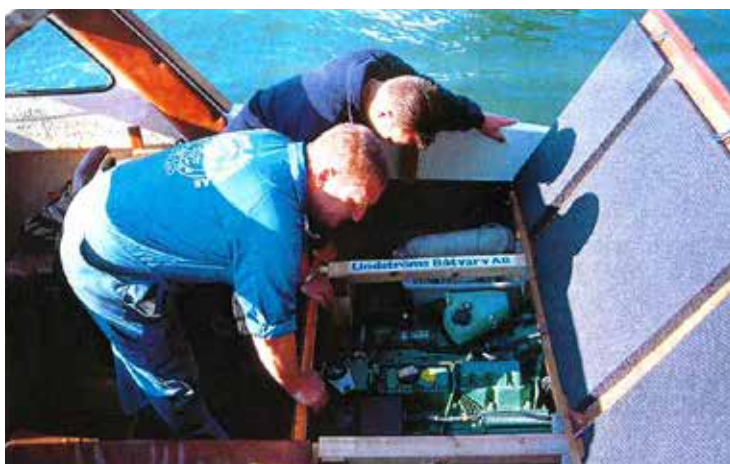
Färdigmonterat. Tungmattor och absorptionsmattor är monterade på motorhuvens insida och på skottet ut mot sittbrunnen.
