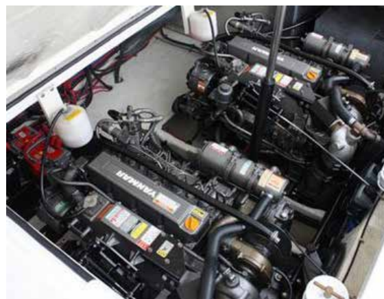
Prydligt motorrum med isolering av skrovsidor runt motorn.
